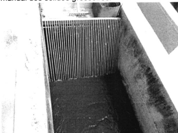
Figura 3 Detalhe do gradeamento com coleta manual dos sólidos grosseiros.
