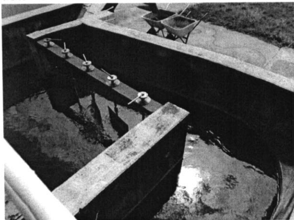
Figura 5 Detalhe da caixa de areia no pré tratamento.
